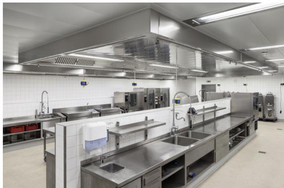
03 Aufgrund der strengen Auflagen des Denkmalschutzes bei der Sanierung der Flora in Köln galt es insbesondere bei der Küchenplanung eine Lösung zu finden, mit welcher die Gastronomie problemlos integriert werden konnte. Durch die Integration der PlasmaStream-Technologie von BÄRO kann die Abluft ohne Verrohrung ins Freie geblasen werden und die Gebäudehülle bleibt frei von großformatigen Abluftkanälen, die das Erscheinungsbild des einzigartigen Flora-Gebäudes gestört hätten.
