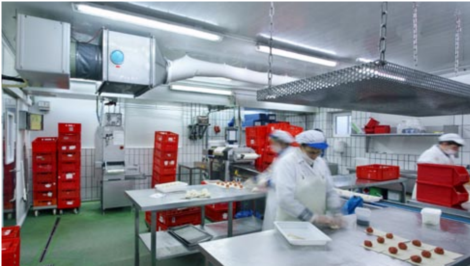
Zwei UV-C-Entkeimungssysteme, als Verdampfer-Vorschaltgeräte positioniert, machen die Fleischzubereitung zur keimfreien Zone
