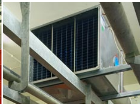
Als Vorsatzgerät des Kühlluftgebläses im Anlieferungsraum für Frischfleisch reduziert das UV-C-Entkeimungssystem von BÄRO das Keimniveau auf nahezu Null
