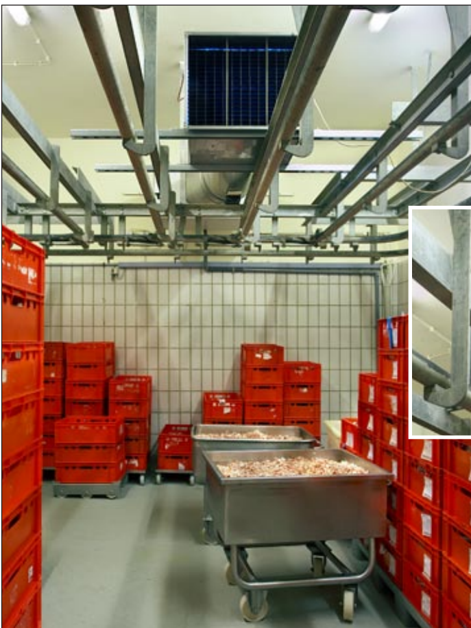
Als Vorsatzgerät des Kühlluftgebläses im Anlieferungsraum für Frischfleisch reduziert das UV-C-Entkeimungssystem von BÄRO das Keimniveau auf nahezu Null
