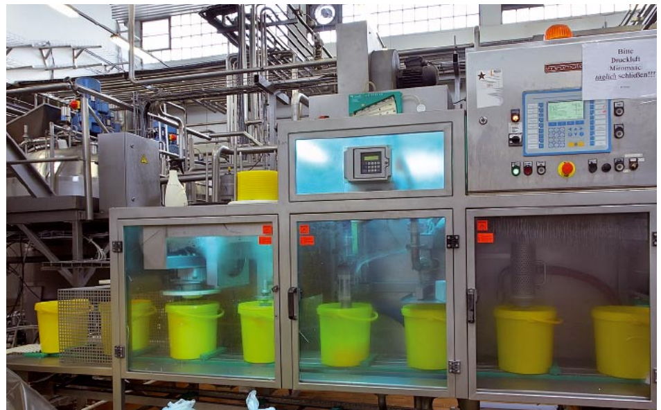
Kontamination mit Mikroorganismen wird in der Abfüllanlage für Großgebinde durch Innenraum-Bestrahlung effizient verhindert.
